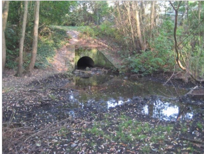
Abbildung 15: Regenwasserauslaufbauwerk (Eigene Fotografie vom 01.05.2019)
