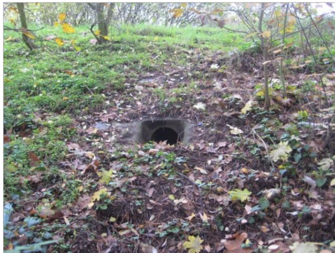
Abbildung 16: Überlauf am nordöstlichen Ende (Eigene Fotografie vom 13.11.2019)
