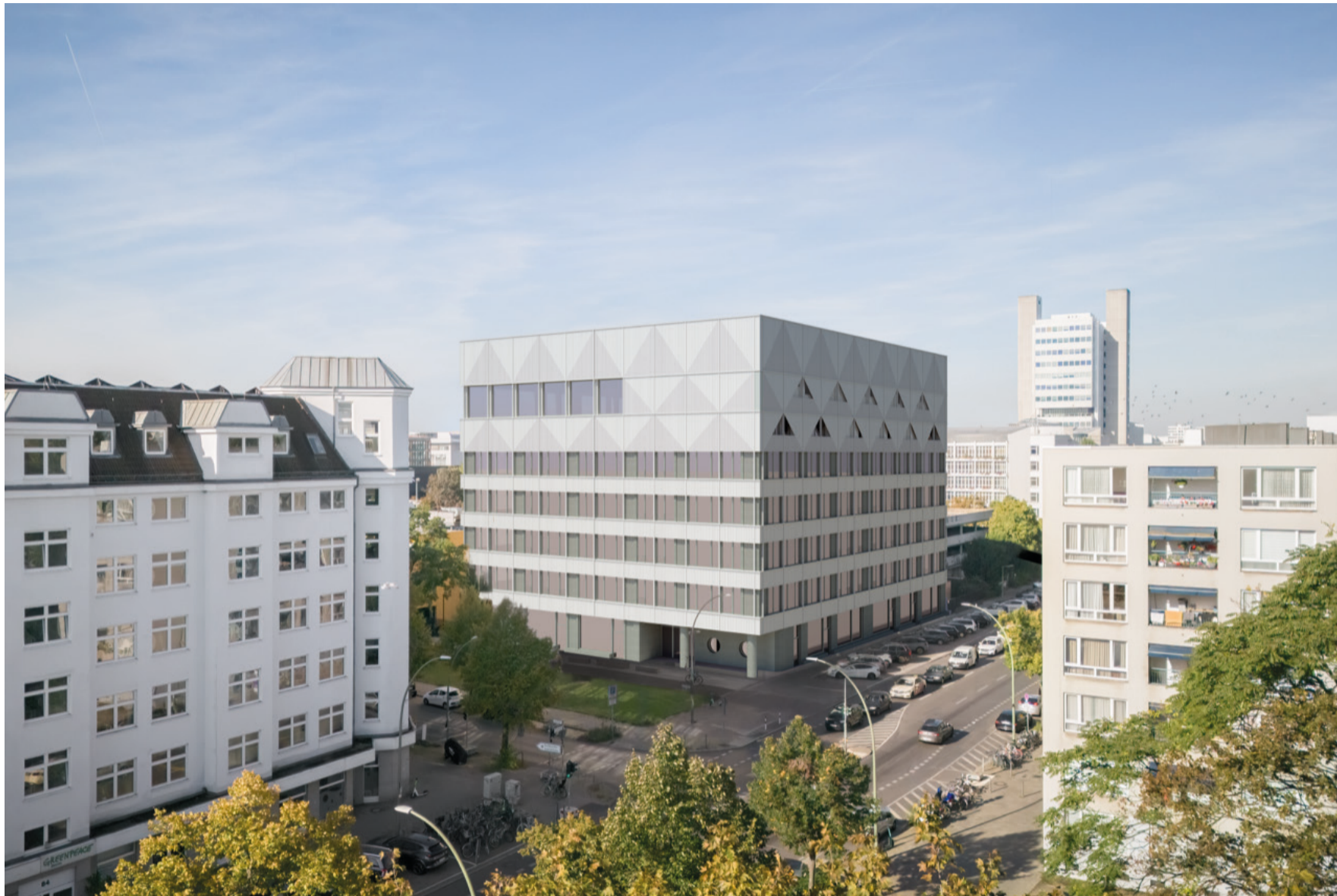
So könnte die Fassade der 2in1-Schule aussehen. Hier wird als Beispiel die Schule in einem innerstädtischen Kontext gezeigt. © ARGE 2in1
