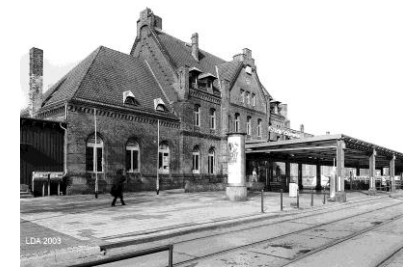
S- und Fernbahnhof Schöneweide Das Bahnhofsgebäude von 1886 ist das älteste erhaltene Bauwerk in Niederschöneweide.
