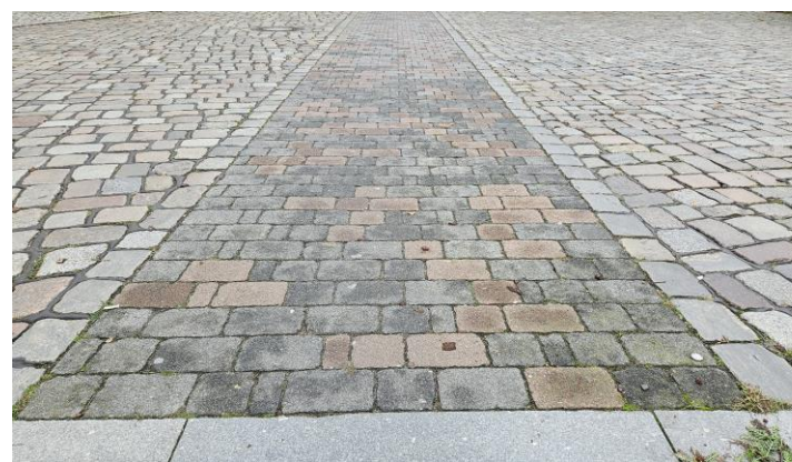
Anpassung Kopfsteinpflaster für Radverkehr, Quelle: stadtraum
