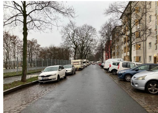
Asphaltierung Natursteinpflaster, Quelle: SenUMVK 2023
