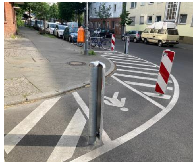
Markierte Gehwegvorstreckung, Quelle: SenUMVK
