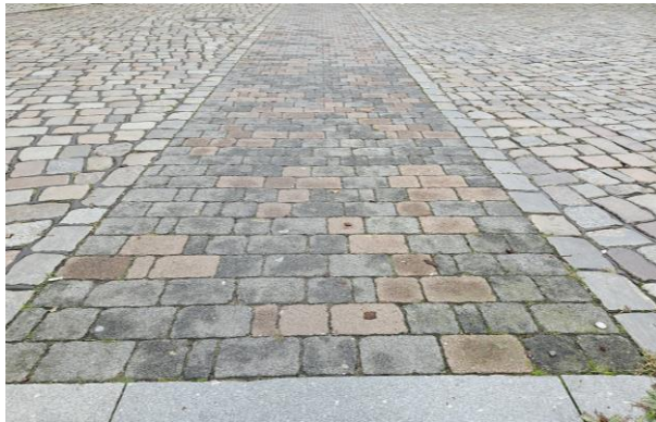
Anpassung Kopfsteinpflaster für Radverkehr, Quelle: stadtraum
