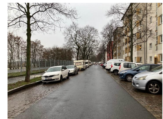
Asphaltierung Natursteinpflaster, Quelle: SenUMVK 2023
