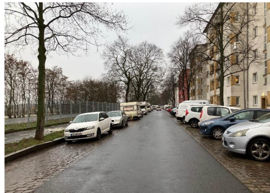
Asphaltierung Natursteinpflaster, Quelle: SenUMVK 2023
