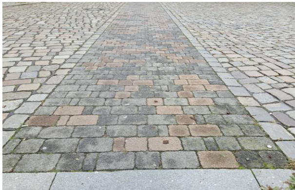
Anpassung Kopfsteinpflaster für Radverkehr, Quelle: stadtraum
