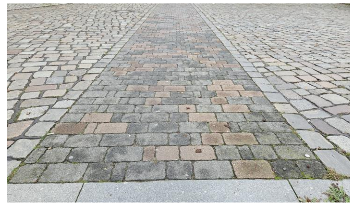
Anpassung Kopfsteinpflaster für Radverkehr, Quelle: stadtraum
