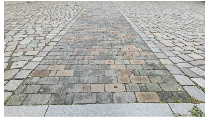
Beispiel Anpassung Kopfsteinpflaster für Radverkehr, Quelle: stadtraum
