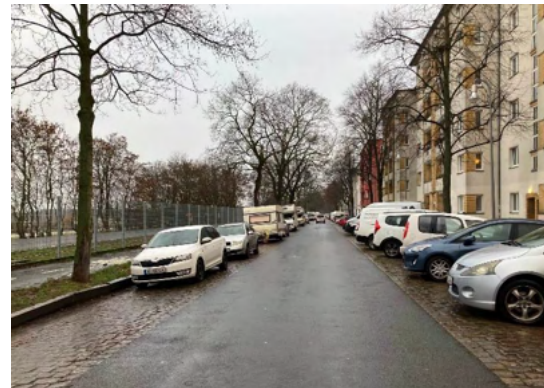
Beispiel, Asphaltierung Natursteinpflaster, Quelle: SenUMVK 2023
