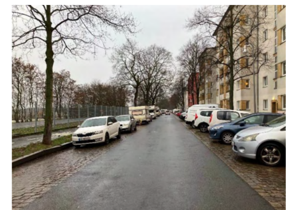
Beispiel Asphaltierung Natursteinpflaster, Quelle: SenUMVK 2023
