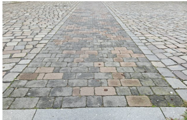
Beispiel, Anpassung Kopfsteinpflaster für Radverkehr, Quelle: stadtraum
