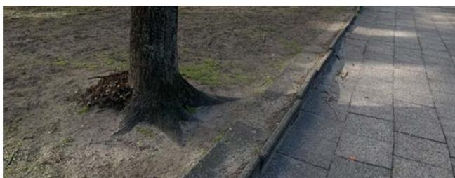
Abb. 47 Stolpergefahr durch angehobene Kantensteine und Platten
