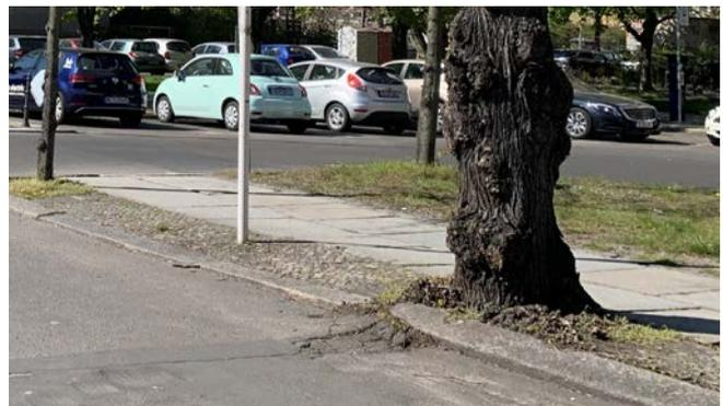
Abb. 45 Sechseck-Insel: Kleine Baumscheiben, schadhafte Fahrbahn
