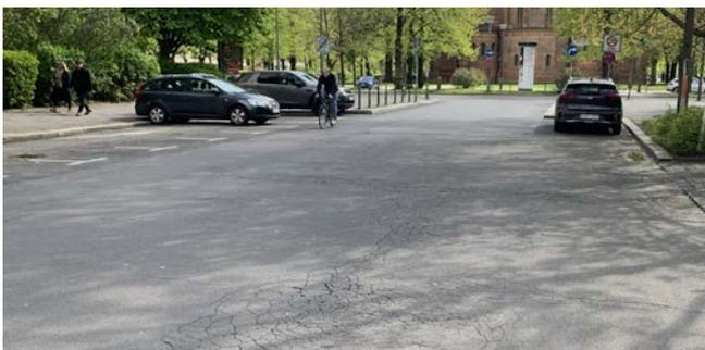
Abb. 52 Der Asphaltbelag der Fahrbahn ist brüchig
