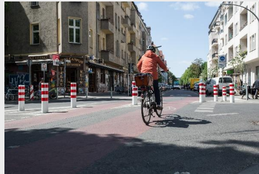
Ausbau der Weserstraße zur Fahrradstraße (in Bau)
