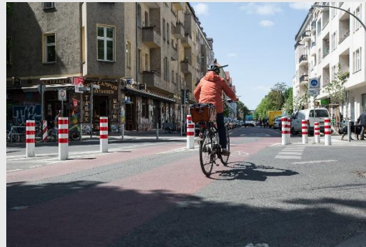
Ausbau der Weserstraße zur Fahrradstraße (in Bau)
