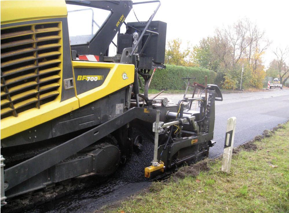
**Abbildung 1: Neuer Asphalt wird aufgebracht**
