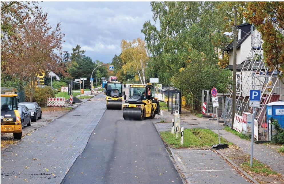
Abbildung 7: Neuasphaltierung der Dahlwitzer Straße (Foto: Straßen- und Grünflächenamt Marzahn-Hellersdorf)
