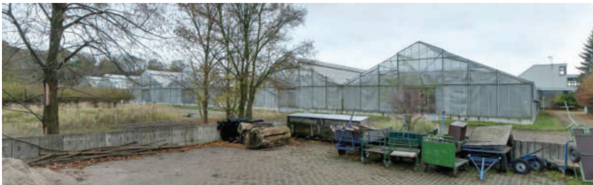
Nördliches Gelände, Blick in Richtung Süd-Südost. Bildhintergrund rechts: Mehrstöckiges Verwaltungsgebäude. (Aufnahme November 2012)
