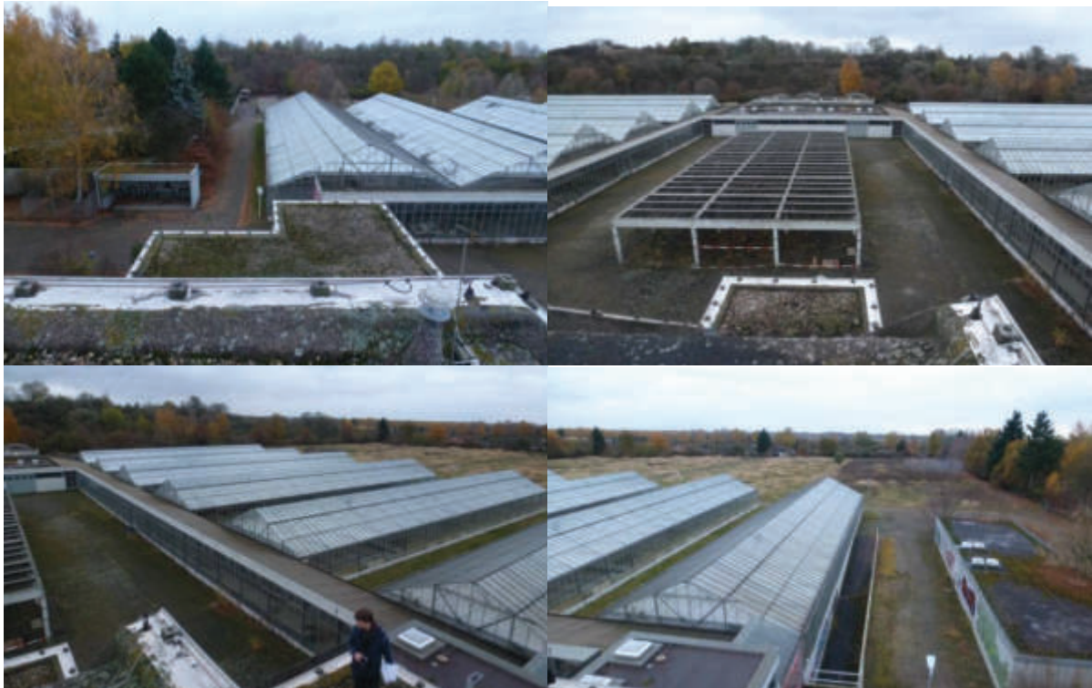
Rundumblick von Verwaltungsgebäude ehemalige Bezirksgärtnerei über Gewächshausanlage (Aufnahme November 2012).
