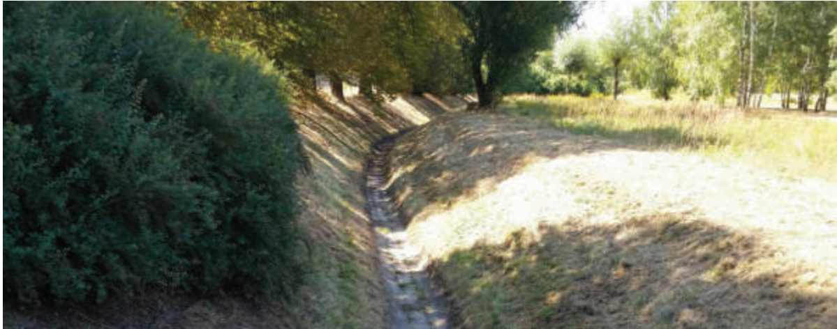
Betonrinne Königsgraben, südlich des Freseteichs. Rechts im Hintergrund verläuft der Weg.
