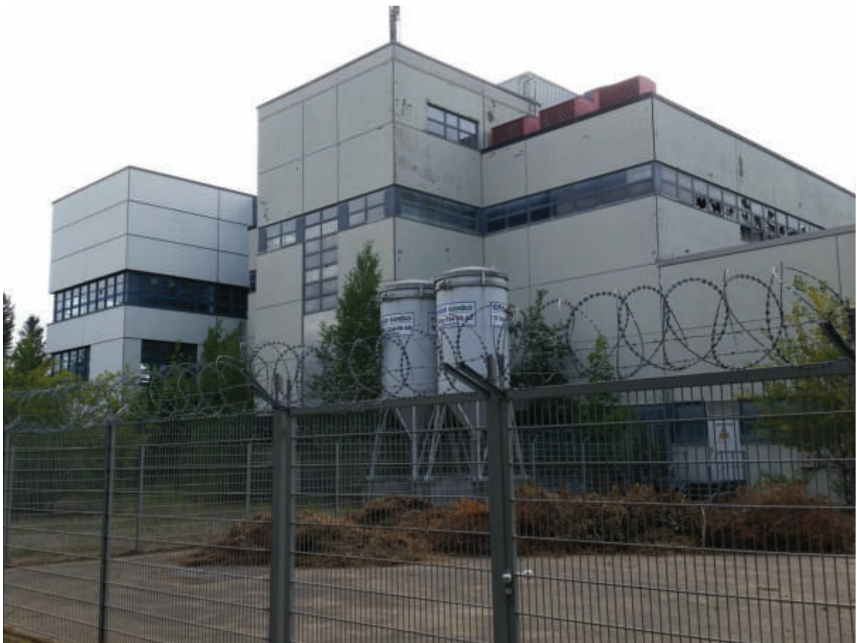
Betriebsgebäude ehemaliges Klärwerk Schichauweg 56, größtenteils ungenutzt. Blick von Betriebsgelände in Richtung Südwesten.
