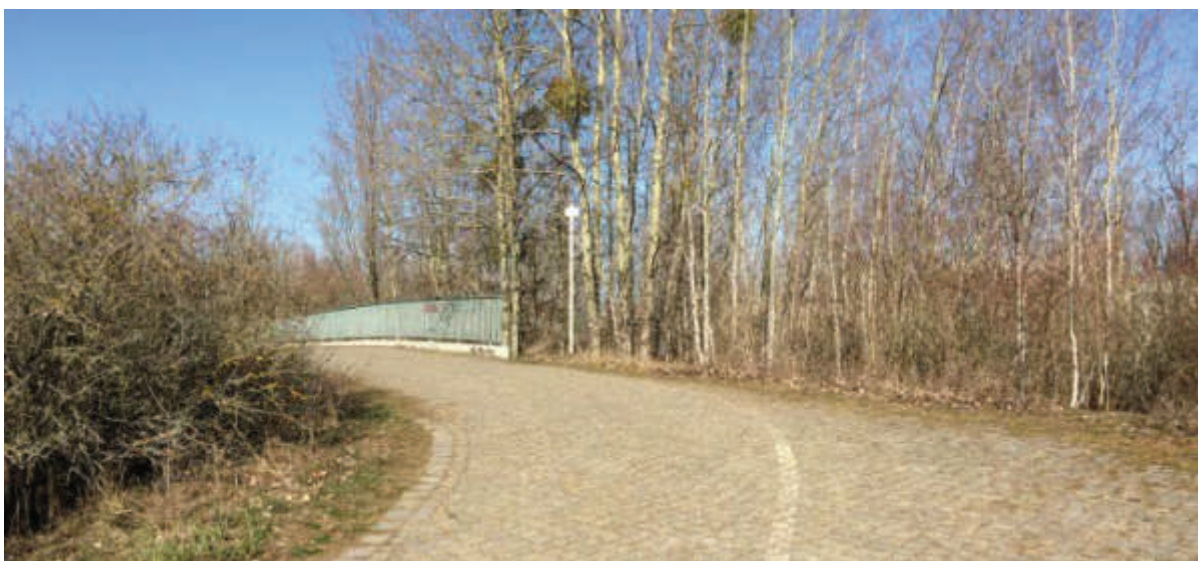
Überführung Grünzug Güteraußenring Adolf-Kiebert-Steg (Aufnahmen Februar 2019).
