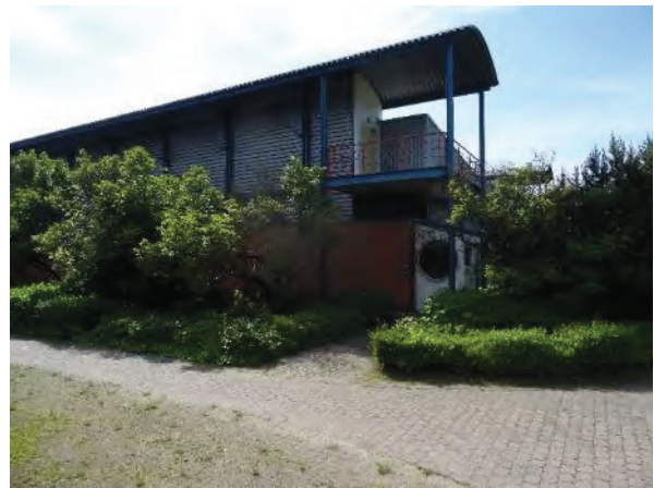
Abbildung 31: dichter Heckenbewuchs an Gebäuden und Wegen dienten Gebüschbrütern zu Nistanlage
