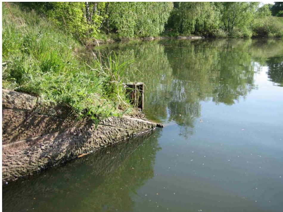
Abb. 11: Ansicht Auslaufbauwerk am 26.4.2007
