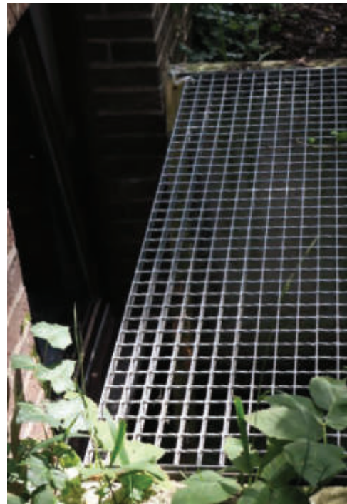
Abb. 69: Lichtschacht am Haus nahe des Waldpfuhls
