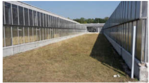
Trockene Bereiche zwischen Gewächshäusern
