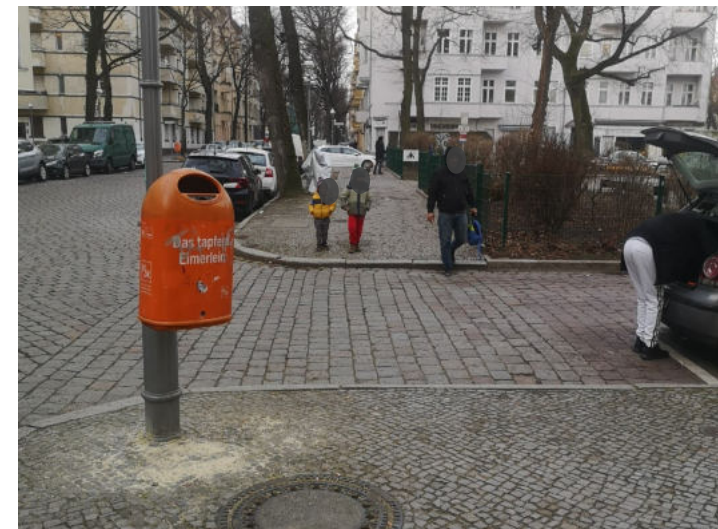
Fehlende Bordabsenkungen am Schierker Platz
