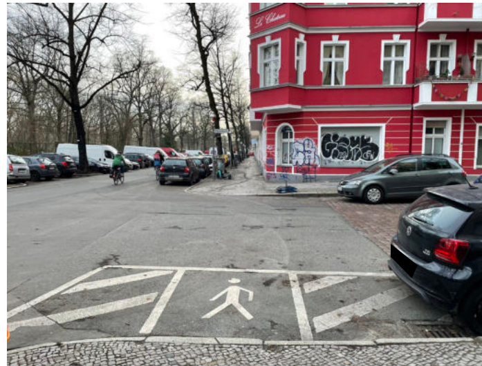
Markierte Querungshilfe nur einseitig vorhanden
