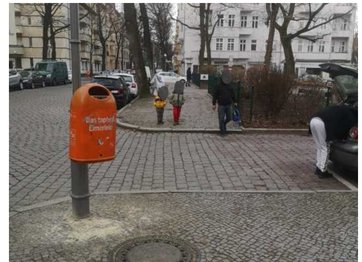
Fehlende Bordabsenkungen am Schierker Platz
