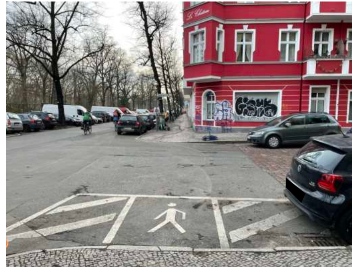
Markierte Querungshilfe nur einseitig vorhanden
