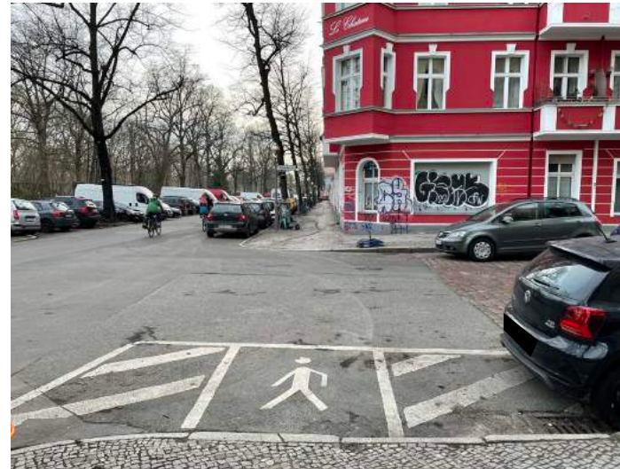
Markierte Querungshilfe nur einseitig vorhanden
