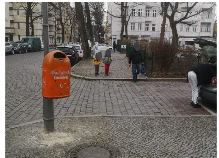
Fehlende Bordabsenkungen am Schierker Platz
