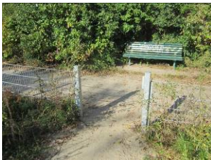
Abb. 11.2: Übergang Spielplatz/Weg: Fehlendes Tor
