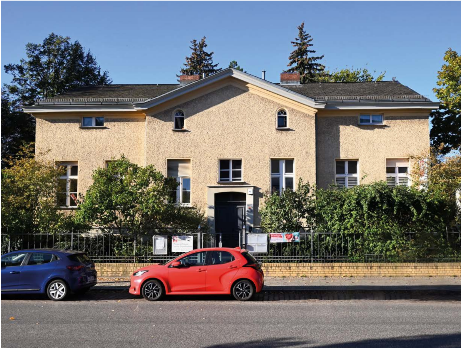
↑ Flach geneigtes Satteldach mit Schiefereindeckung, Alt-Rudow 42
