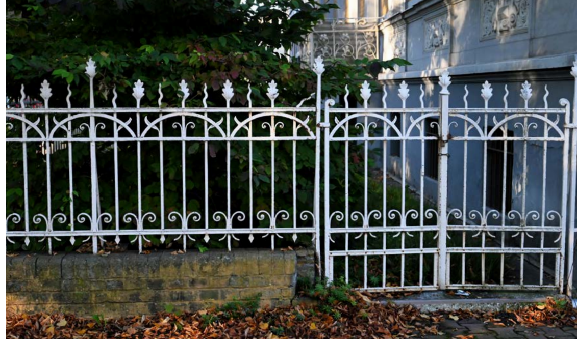
↑ Schmiedeeiserner Zaun auf Zaunsockel aus Klinkermauerwerk, Köpenicker Straße 180
