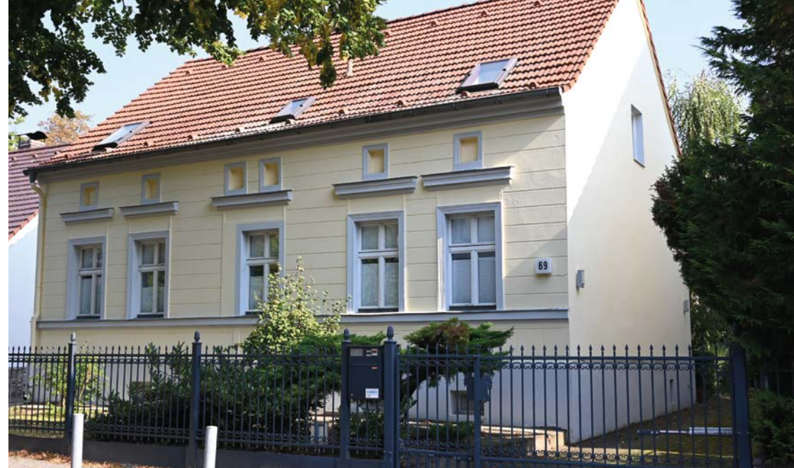
↑ Im Original erhaltene Fassadengestaltung, Prierosser Straße 69
