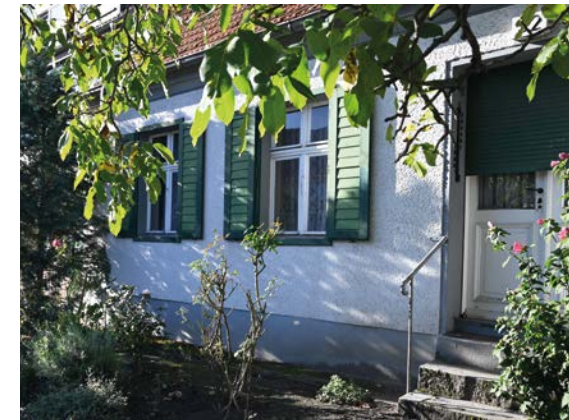
↑ Stadtbildprägendes Gebäude Alt-Rudow 32 (bäuerliches Wohnhaus, erbaut um 1820)
