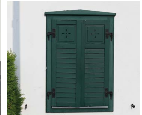
↓ Hölzerne Fensterläden, Krokusstraße 80
