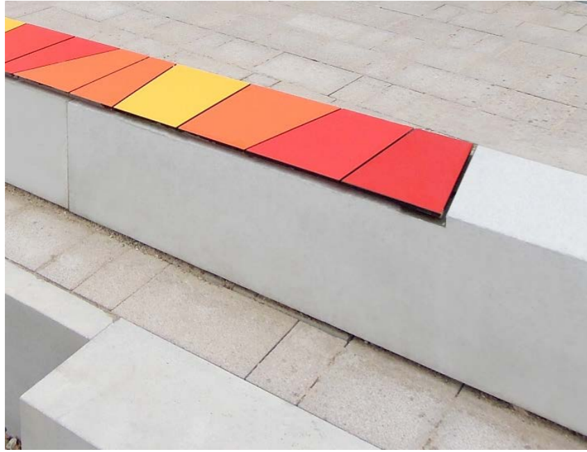
Betoneinfassung mit Sitzauflagen
