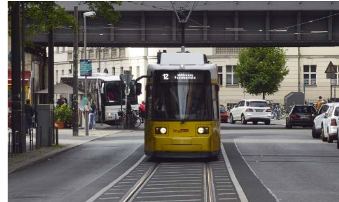
Straßenbündiger Bahnkörper, abmarkiert, ggf. mit anderer Pflasterung
