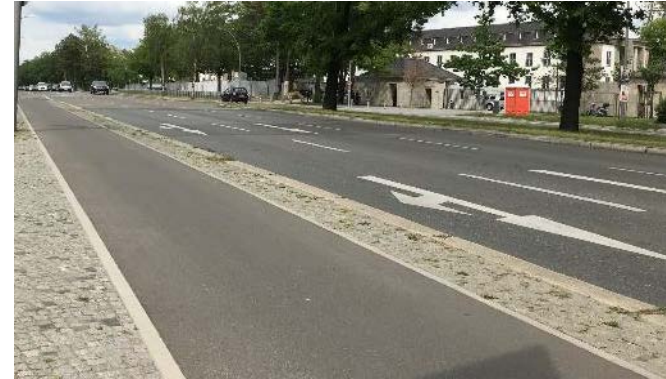
Baulicher Radweg als Protektion
