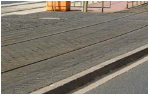
Besonderer Bahnkörper (gepflastert), 8 cm Bord
