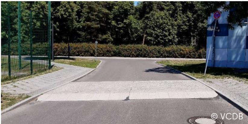
*Oben: Aufpflasterung mittig mit Vorbeifahrmöglichkeit*
