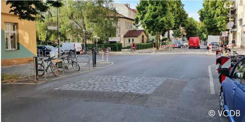
Anhebung von Teilen der Fahrbahn, Rampenneigung je nach angestrebtem Geschwindigkeitsniveau
