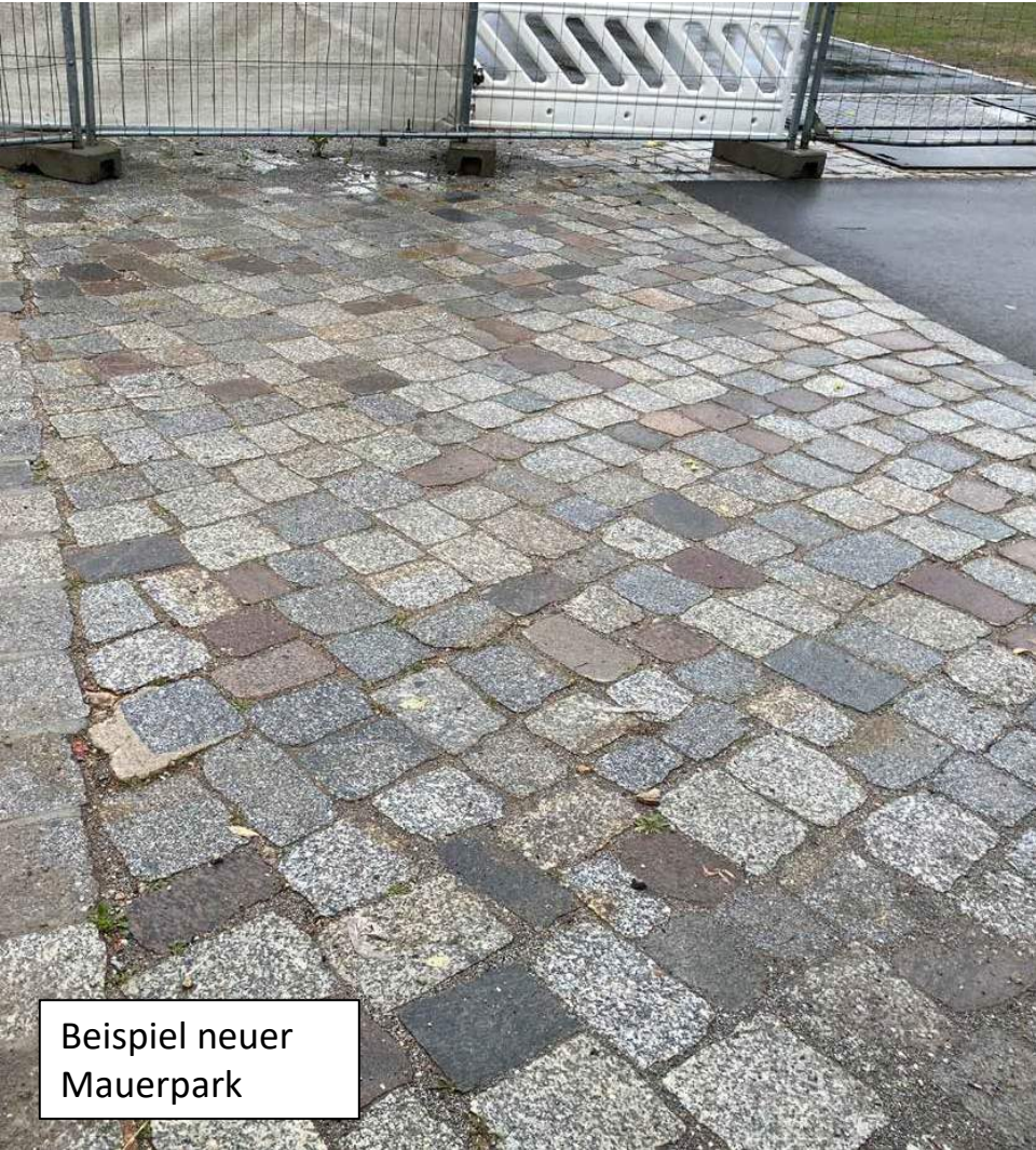
Vollständiger Einbau von gesägtem Pflaster
