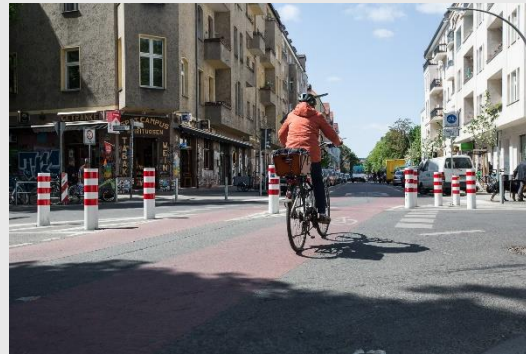
Ausbau der Weserstraße zur Fahrradstraße (in Bau)
